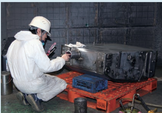
▲ 燃料タンクの内面塗装
